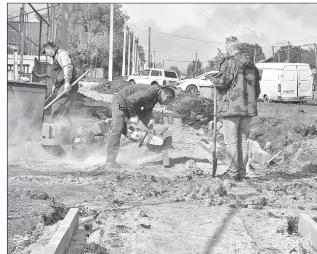
Установка бордюров на тротуаре к «Колокольчику»
