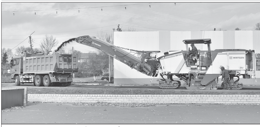
Снятие асфальтного покрытия
