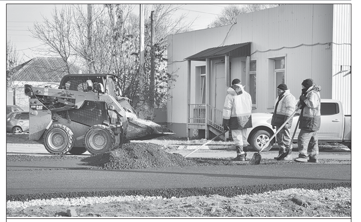
Укладка нового асфальта
